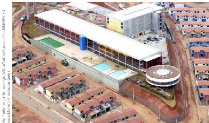
CENTRO EDUCACIONAL UNIFICADO (CEU) INÁCIO MONTEIRO, CIDADE TIRADENTES, SÃO PAULO – SP.
