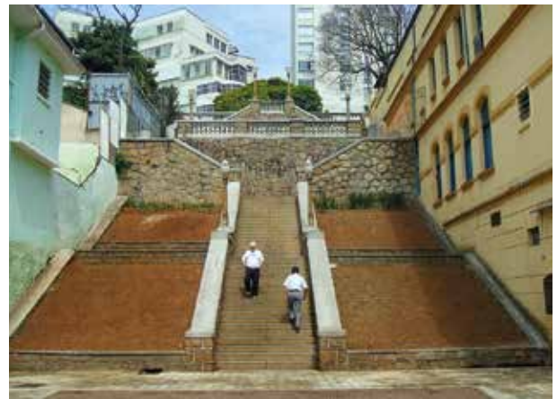
ESCADARIA DO BIXIGA, NO BAIRRO DO BIXIGA, SÃO PAULO.
