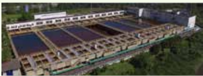
ESTAÇÃO DE TRATAMENTO DE ÁGUA EM SÃO PAULO (SP) - SABESP
