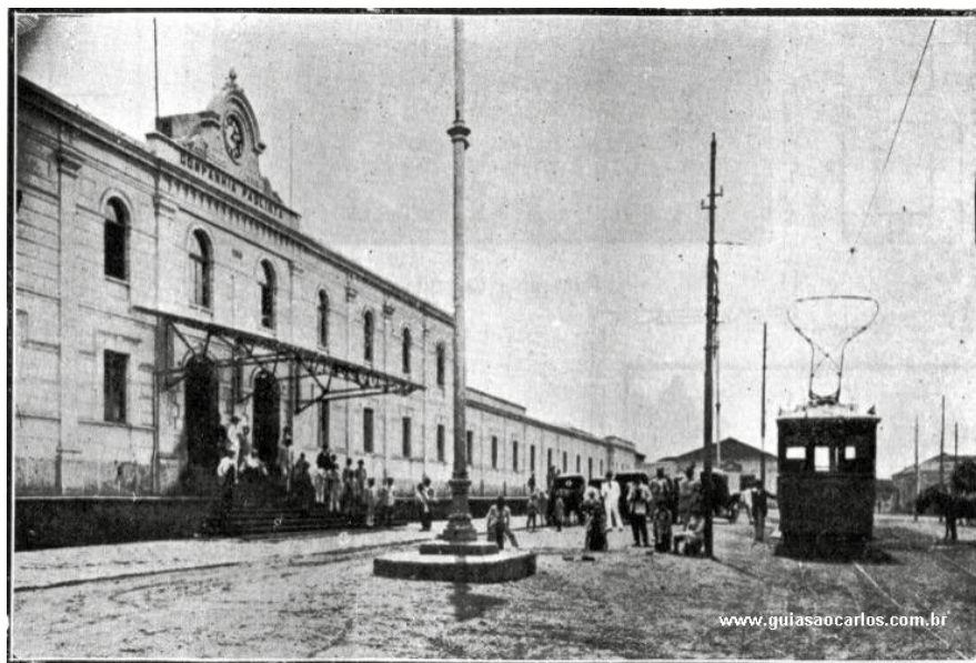
Vista da Estação Ferroviária de São Carlos e do bonde em 1918.
