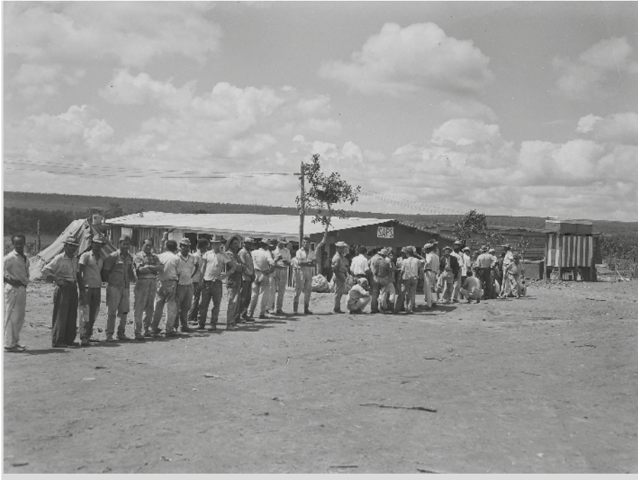
Operários na construção de Brasília.
