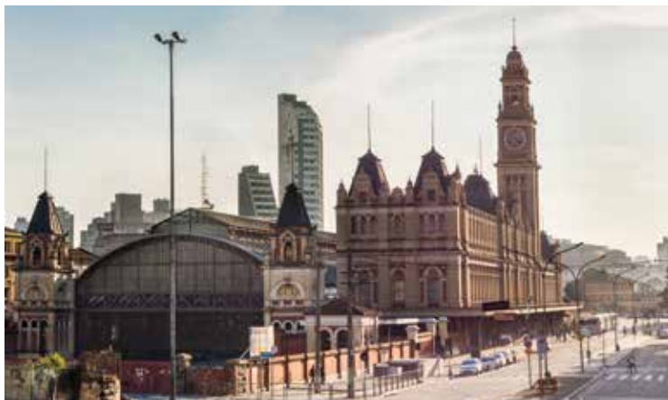
Estação da Luz em 2015, São Paulo.
