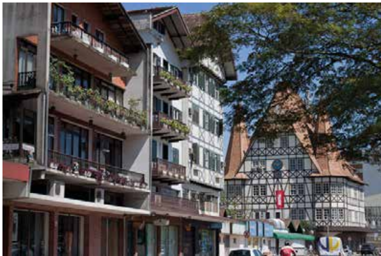
Imagem 3 – Construções feitas em enxaimel, no centro da cidade de Blumenau-SC
