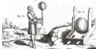
A máquina eletrostática de Otto von Guericke, que soltava faíscas entre as esferas.
